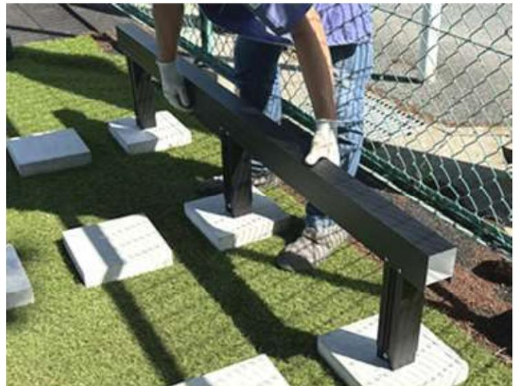
■束柱を固定したら、平板の上に配置していきます。
