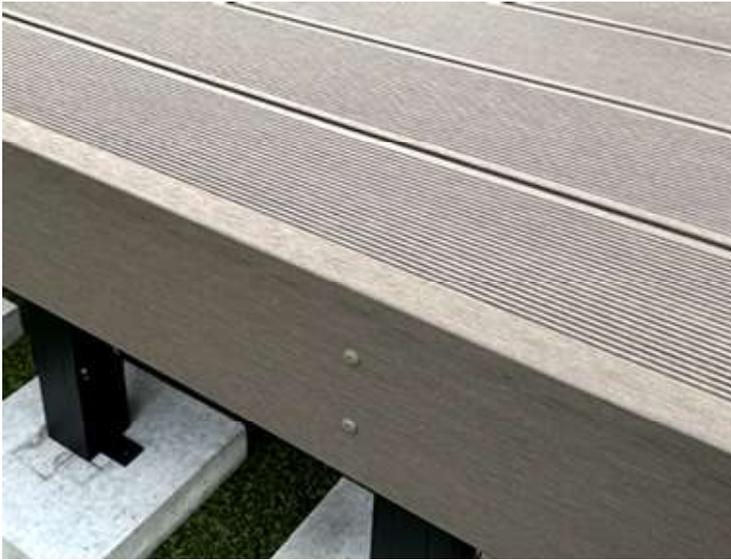
■上下2箇所ずつビスで固定したら幕板の設置が完了です。
