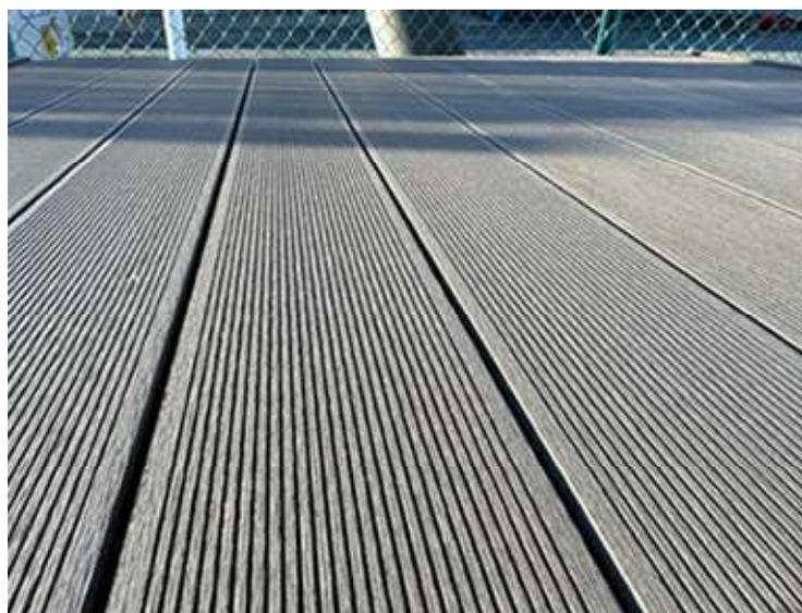
■床板がすべて固定されました。次は側面の幕板を設置していきます。
