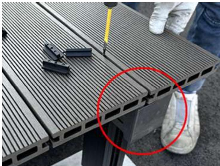
■まず1枚目の床板は、「幕板固定金具」の側面を合わせて配置します。次に2枚目の床板との間に、「固定具」を挟み込んでビス止めしていきます。※1枚ずつ床板を用意してビス止めを行ってください。
