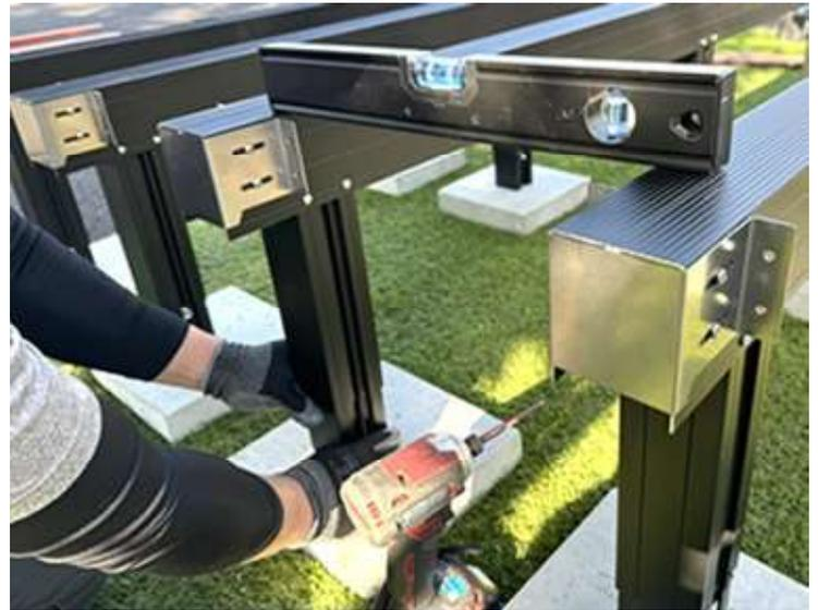
■続いて、全体の高さ調整を行っていきます。まずは仮止めしたボルトを緩めて、束柱を調整できるようにします。
