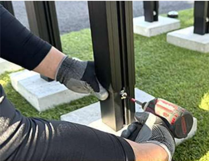
■水平器を見ながら隣の高さがそろった場所で、再度ボルトを仮止めます。
