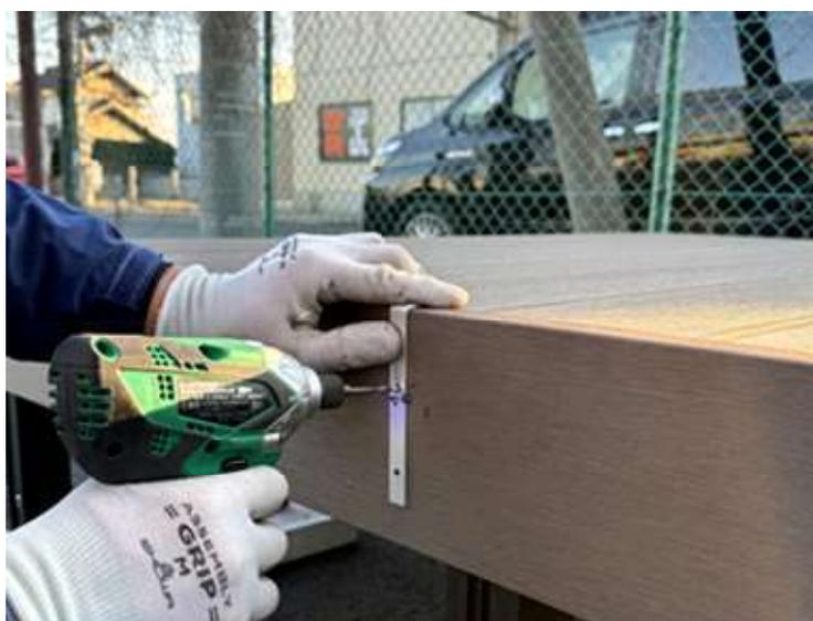
■専用の治具を使用して、内側にある「幕板固定金具」の場所に合わせて下穴を開けていきます。
