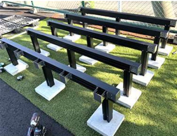
■これで下地の完成です。次は付属のL型金具を使用して、束柱と平板にビス止めします。
