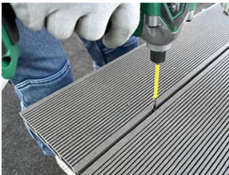
■「床板固定金具」を間に挟み込み、大引きに対して上からドリルビスを打ち込みます。
