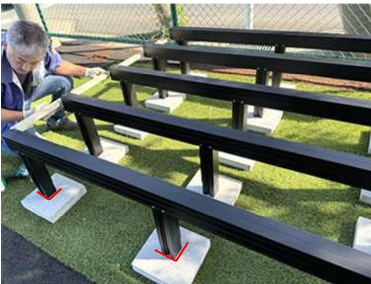
■全ての大引きを配置したら、縦横の通りや寸法を揃えていきます。平板の微調整もここでしています。
